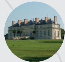
Château du Pont-Hus
